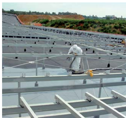
Detalle del acabado de la cubierta del edificio de la Hemeroteca
