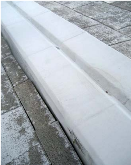
Detalle aplicación membrana CONIPUR M800 sobre junta de dilatación
