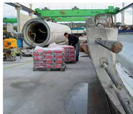
Anclaje de aerogeneradores con MASTERFLOW®
