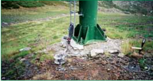
Zapatas sobre las que se anclan las torres de los telesillas antes de su reparación
