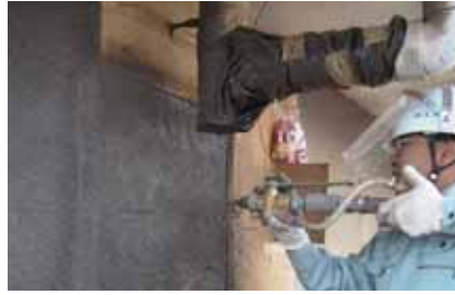
▲ Emaco® CP 60 proyectado en vertical con un grosor de sólo 8 mm.
