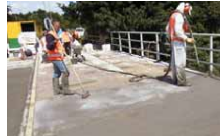
▲ Emaco® CP 60 proyectado horizontalmente sobre tablero de puente
