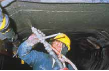
▲ Aplicación por proyección del ánodo Emaco® CP 60.
